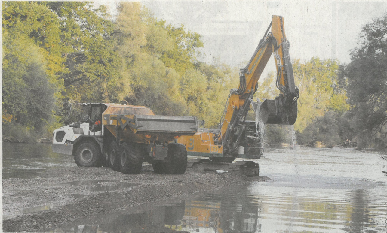
Auf einer aufgeschütteten Kiesbank mitten in der Reuss arbeiten aktuell ein Bagger und ein Lastwagen.
