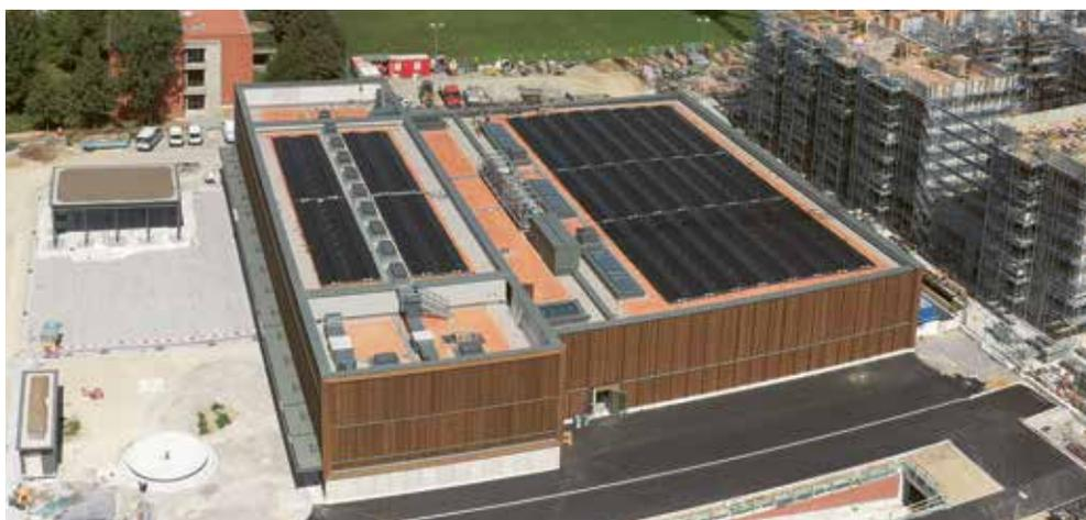
Die zweiteilige Solaranlage nutzt die verbleibende Dachfläche gut aus
