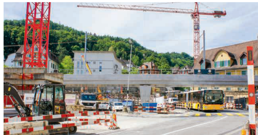
Herausfordernd: Der Einschub der neuen Brücke in Baden
