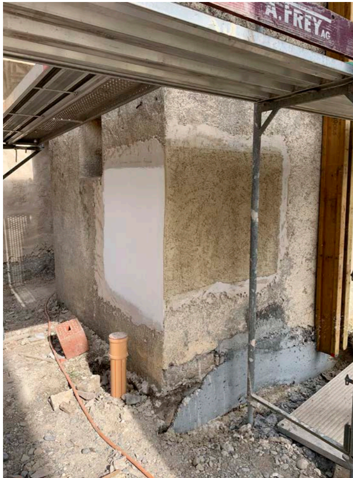
Auf das alte Bruchsteinmauerwerk trugen die Handwerker historischen Kalkputz auf
