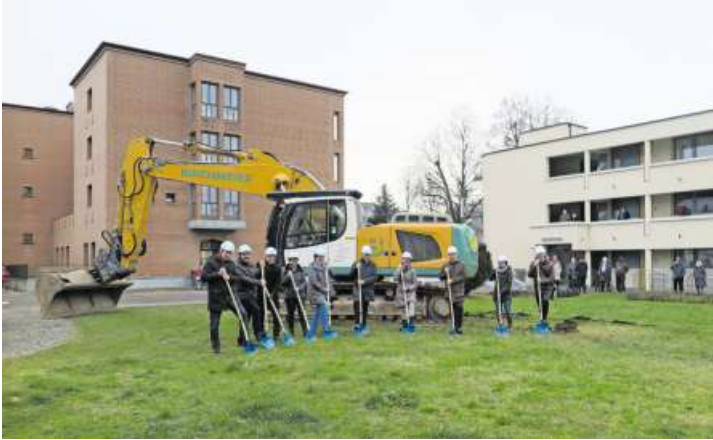
Der Spatenstich erfolgte am Montag.
