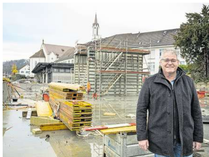
Spitaldirektor René Huber führt durch die Baustelle.
