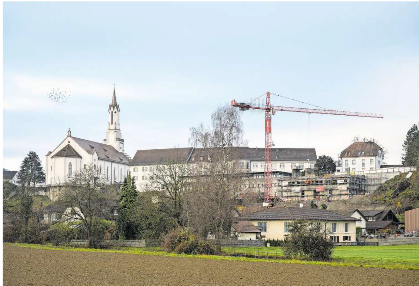
Der Rohbau des Radiologieanbaus des Asana Spital Leuggern auf der rechten Seite ist gut sichtbar.
