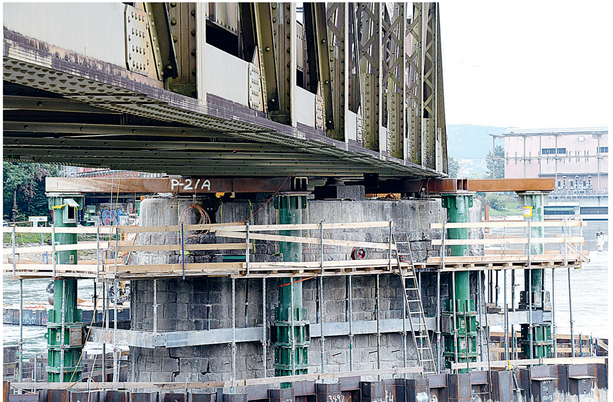
Damit der Kopf des Pfeilers zurückgebaut und neu betoniert werden kann, muss der Brückenträger hydraulisch um einige Millimeter hochgepresst und auf eine Abfangkonstruktion mit horizontal liegenden Stahlträgern auf massiven Stahlstützen (grün) umgelagert werden.
