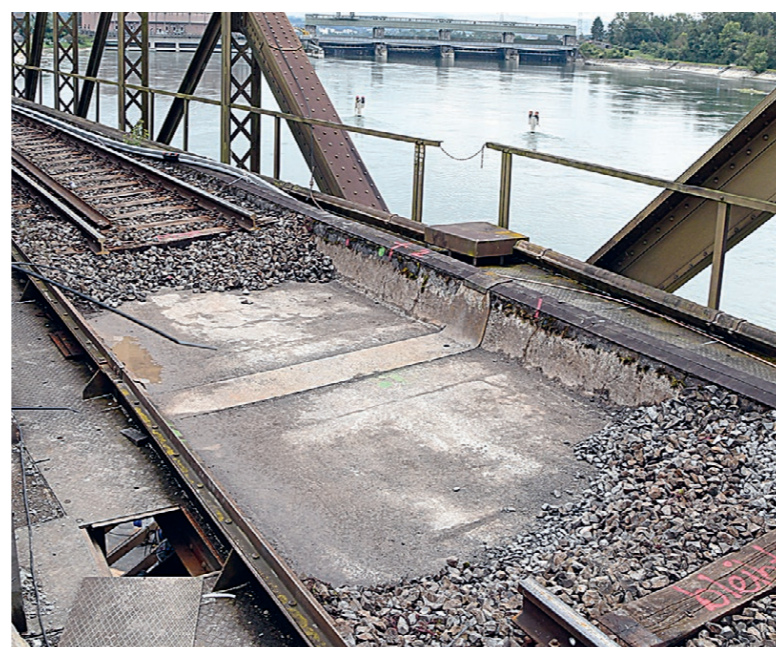
Über dem Pfeiler sind auf einem Abschnitt Gleise und Schotter entfernt worden. An den grünen Punkten wird später angesetzt für die Bohrlöcher, in die dann die Vorspannstangen, die durch den Pfeiler gehen, eingeführt werden.
