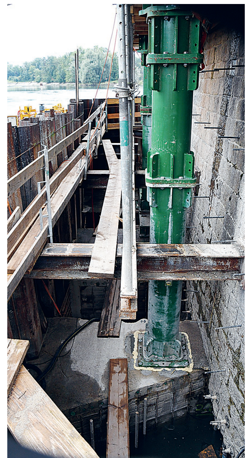
Die Stahlstützen stehen ihrerseits auf einem Fundamentriegel, der am Fuss des Pfeilers neu betoniert wurde. Der ganze Pfeiler wird durch einen sehr robusten Spundwandkasten trocken gehalten.
