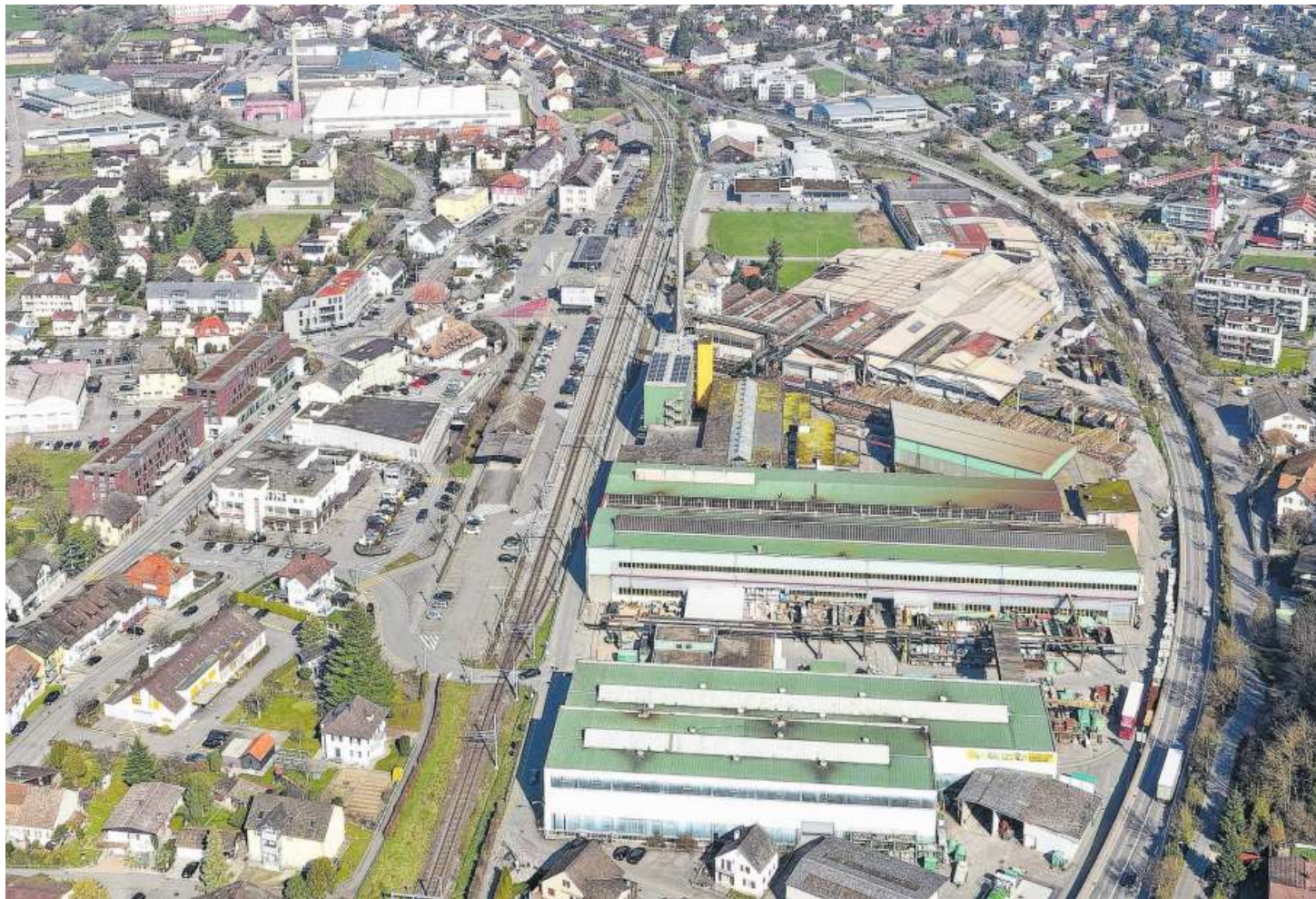
Im Gewerbegebiet in Döttingen rechts der Gleise sollen die Industriehallen von Birchmeier und Hess Hochhäusern weichen.
