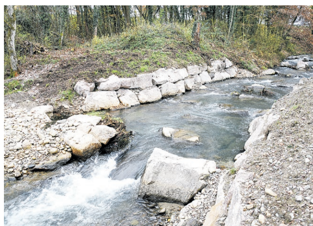
Oberhalb der Eisenbahnbrücke Koblenz-Felsenau sind am rechten Ufer neue Bühnen entstanden, auf der linken Stauseeseite fliesst der Bach des Sickergrabens neu in kleinen Kurven und über Blocksteinschwellen in den Gippinger Grien.
