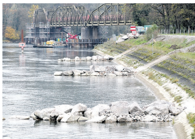
Oberhalb der Eisenbahnbrücke Koblenz-Felsenau sind am rechten Ufer neue Bühnen entstanden, auf der linken Stauseeseite fliesst der Bach des Sickergrabens neu in kleinen Kurven und über Blocksteinschwellen in den Gippinger Grien.
