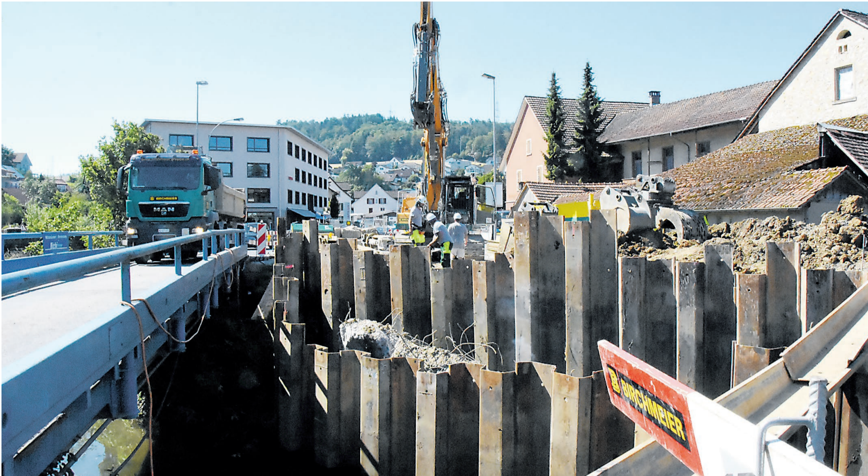
Die erstellte Hilfsbrücke führt den Verkehr über die Surb, daneben sind noch Elemente der alten Brücke erkennbar.
