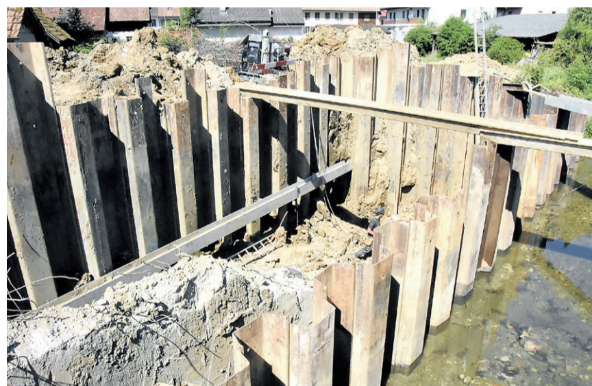
Innerhalb der Spundwandkästen lässt es sich im Trockenen arbeiten.
