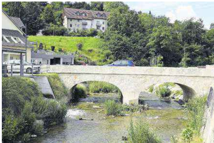
1827 gebaut, nun neu renoviert: die Surbbrücke. Bild: Alexander Wagner
