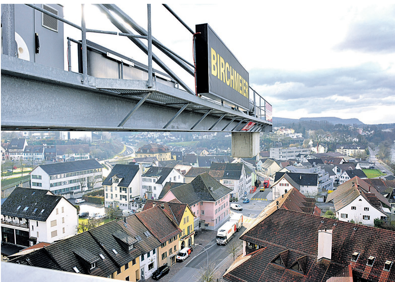
Blick zur Kranterrasse: Im Hintergrund die Betongegengewichte, die den Kran im Lot halten.
