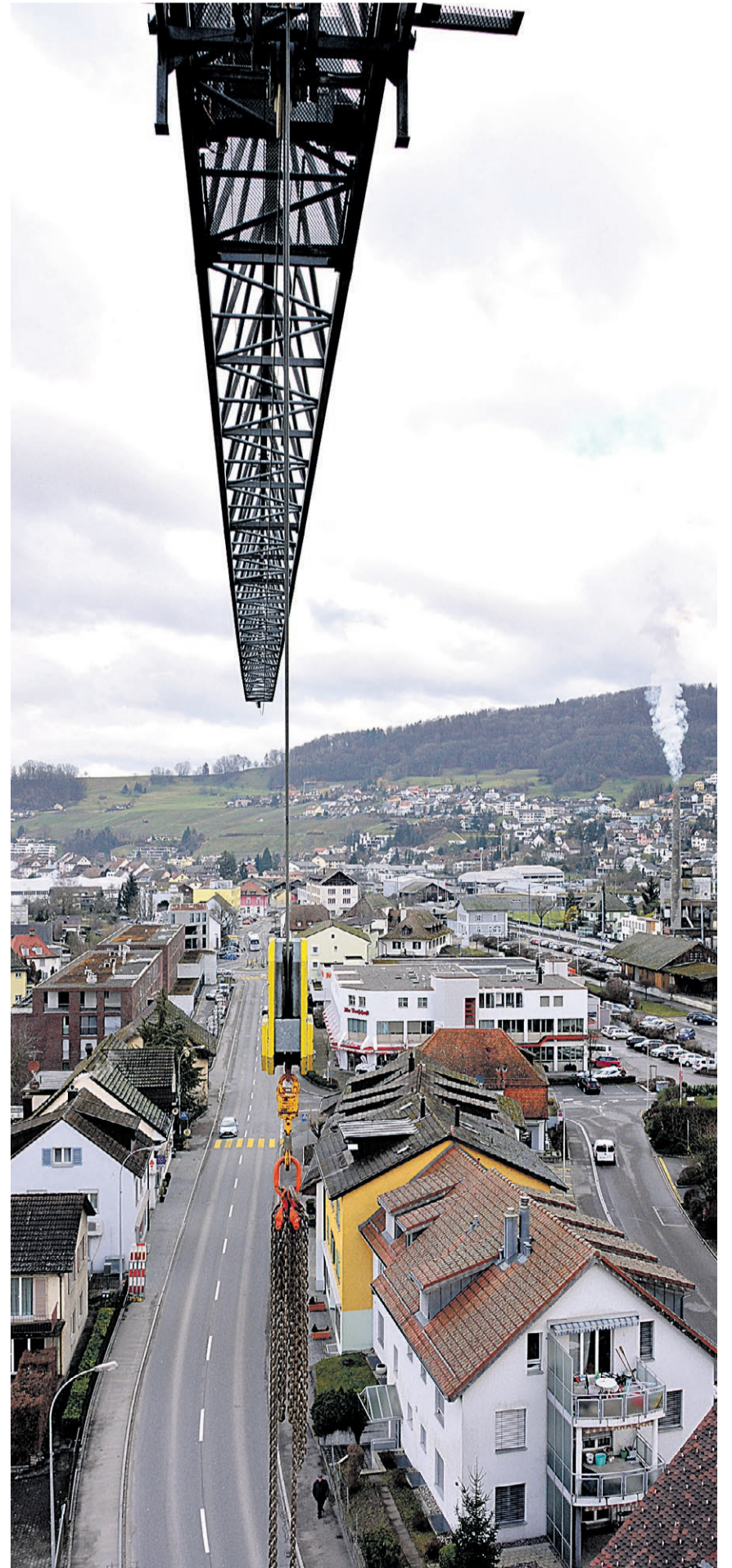
Der 60-Meter-Ausleger reicht weit über die Baustelle hinaus.
