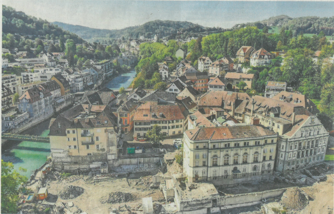
Blick auf die Baugrube im Badener Bäderquartier: Im Jahr 2021 soll das neue Thermalbad eröffnet werden.
