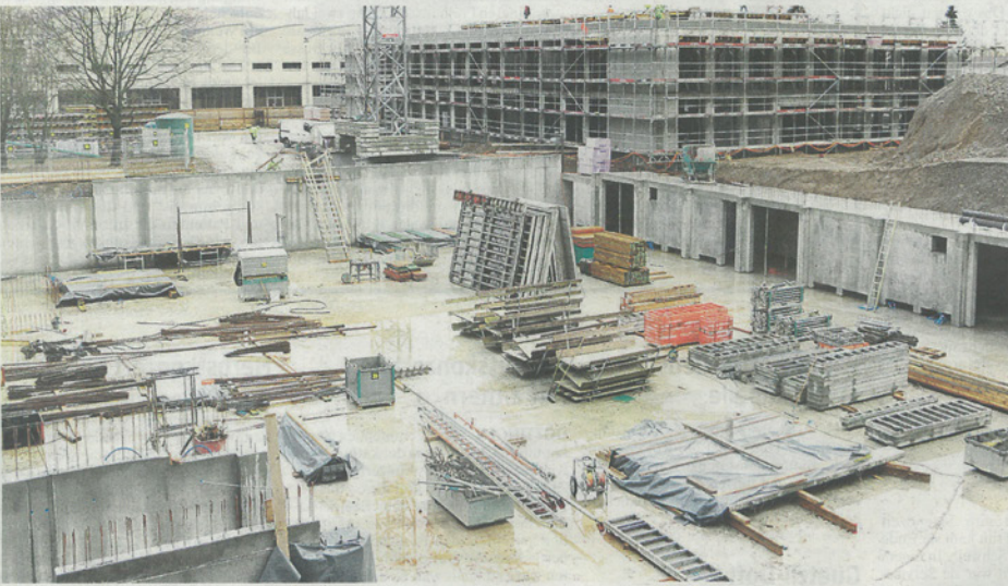
Die in den Boden versenkte Zweifachturnhalle mit dem Schulhaus im Hintergrund.
