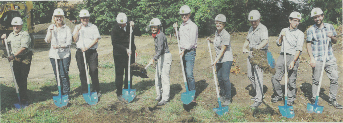
Der Spatenstich am Ort, wo der Anbau an das bestehende Gebäude entstehen wird.
