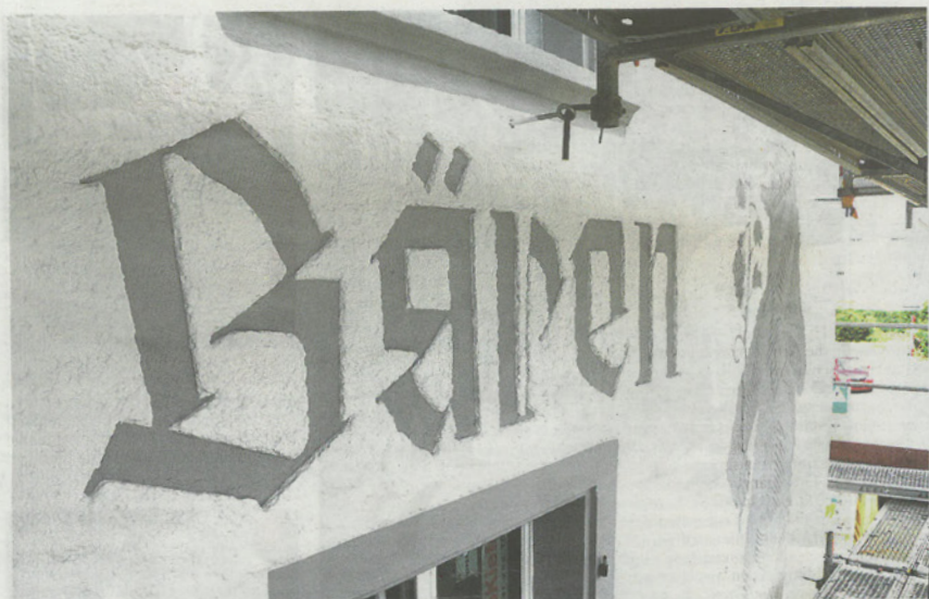
Blick vom Gerüst auf die frisch gestrichene Fassade.
