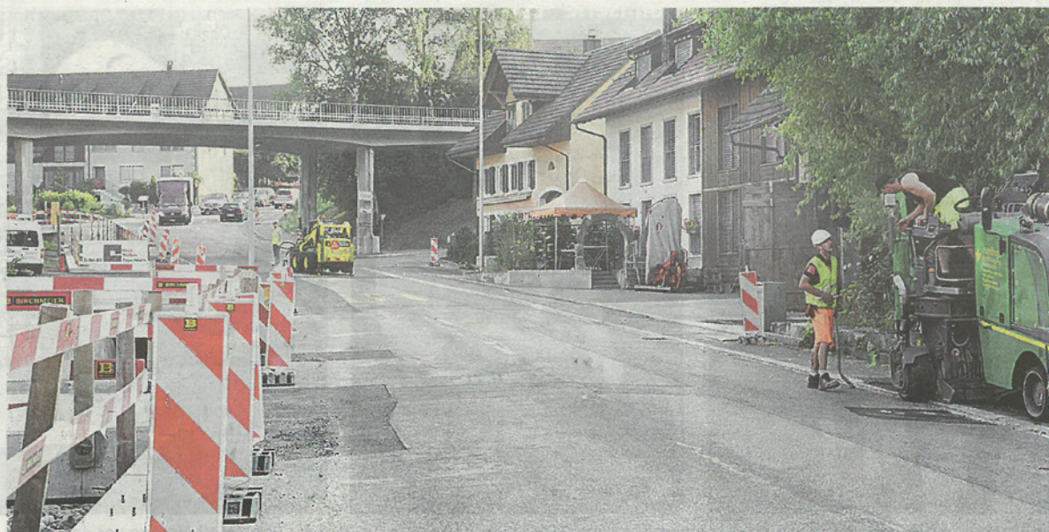
Heute morgen begannen die Fräsarbeiten an den Schachtdeckeln im Staltig Tegerfelden.
