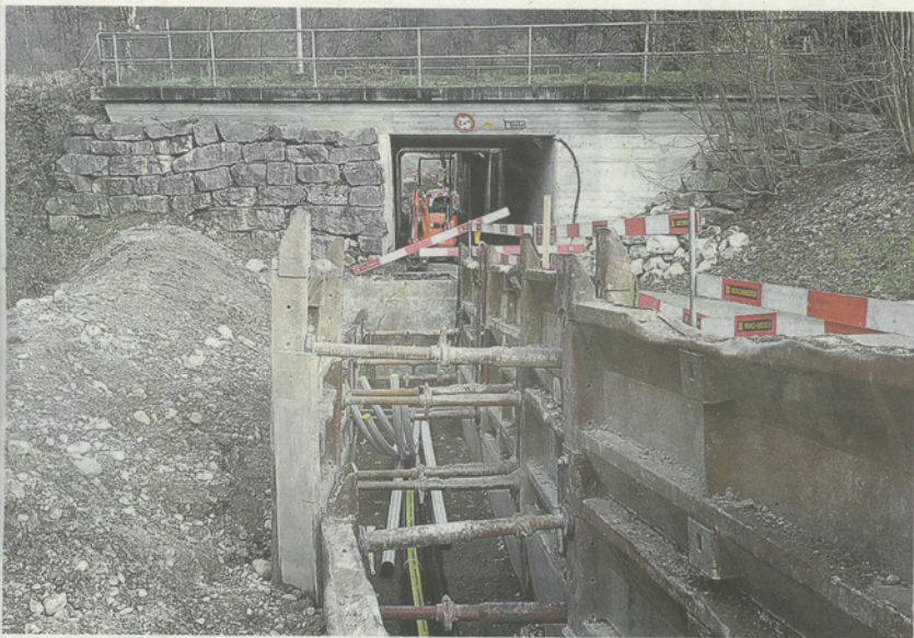
Die Leitungsführung unter dem ganzen Bauwerk durch. Noch offen ist, ob die Trockensteinmauer im Hintergrund durch eine Steinkorbwand ersetzt wird.
